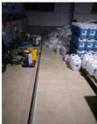
罐区防渗围堰
