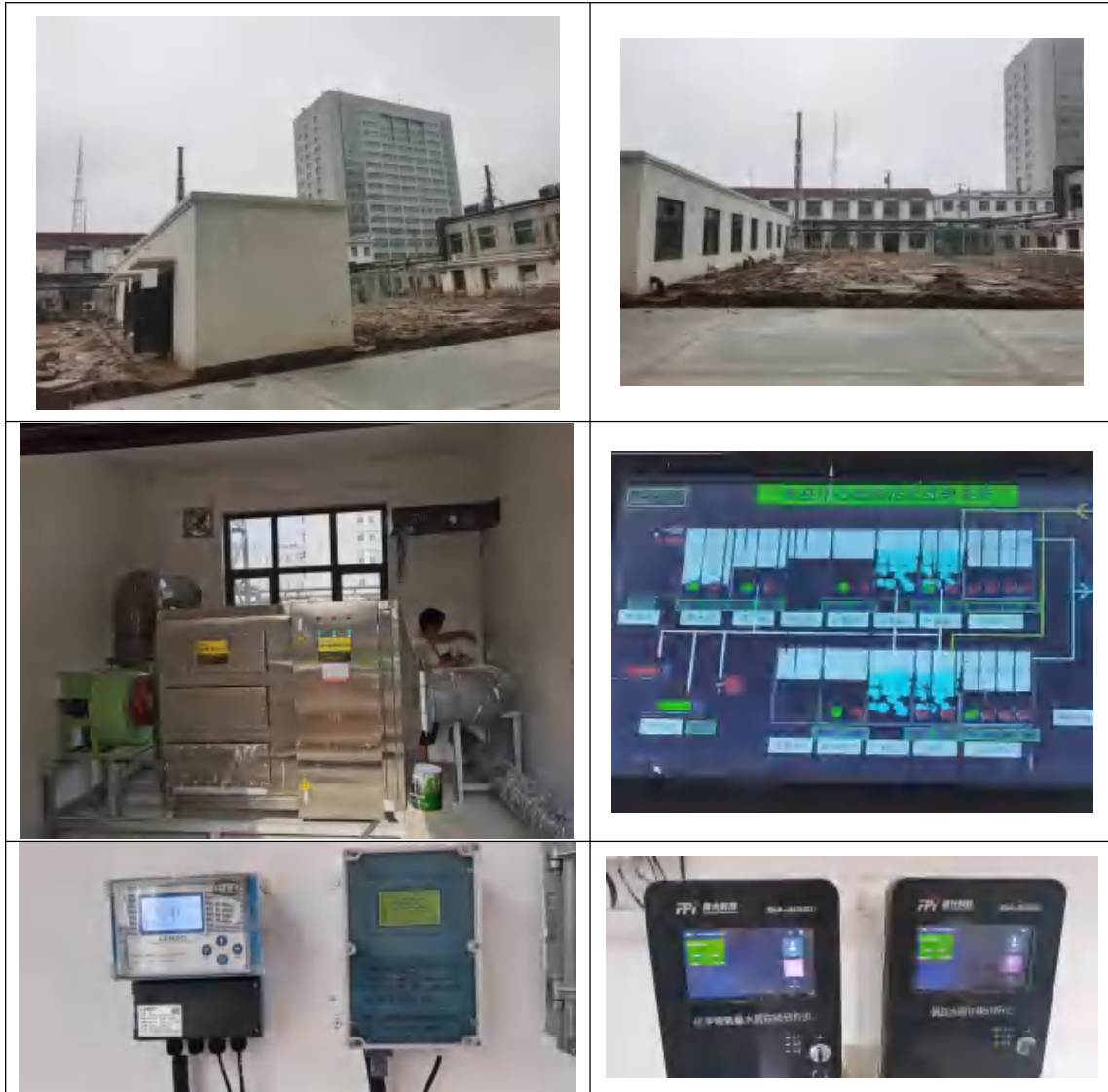
图 3-1 污水处理工程相关图片
